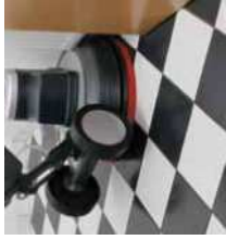
Arbeiten bis zum Rand
