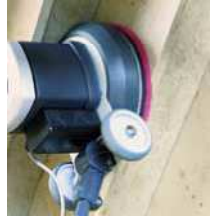
Arbeiten bis zum Rand
